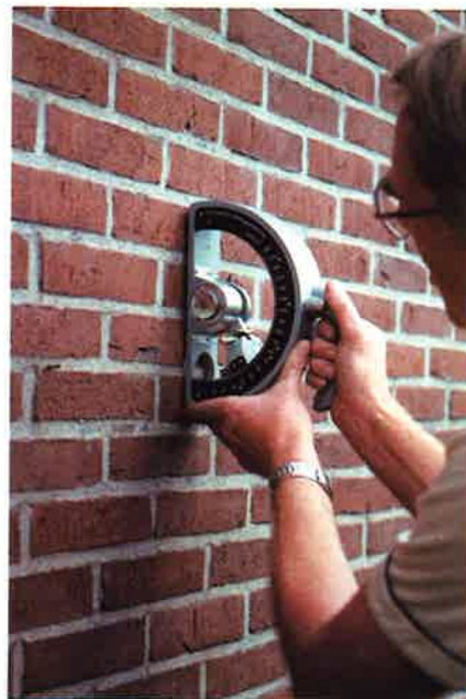
De meest prijsgunstige manier van doorstrijken is na het vol en zat metselen slechts uitkrabben en vervolgens met een harde bezem het metselwerk naborstelen
