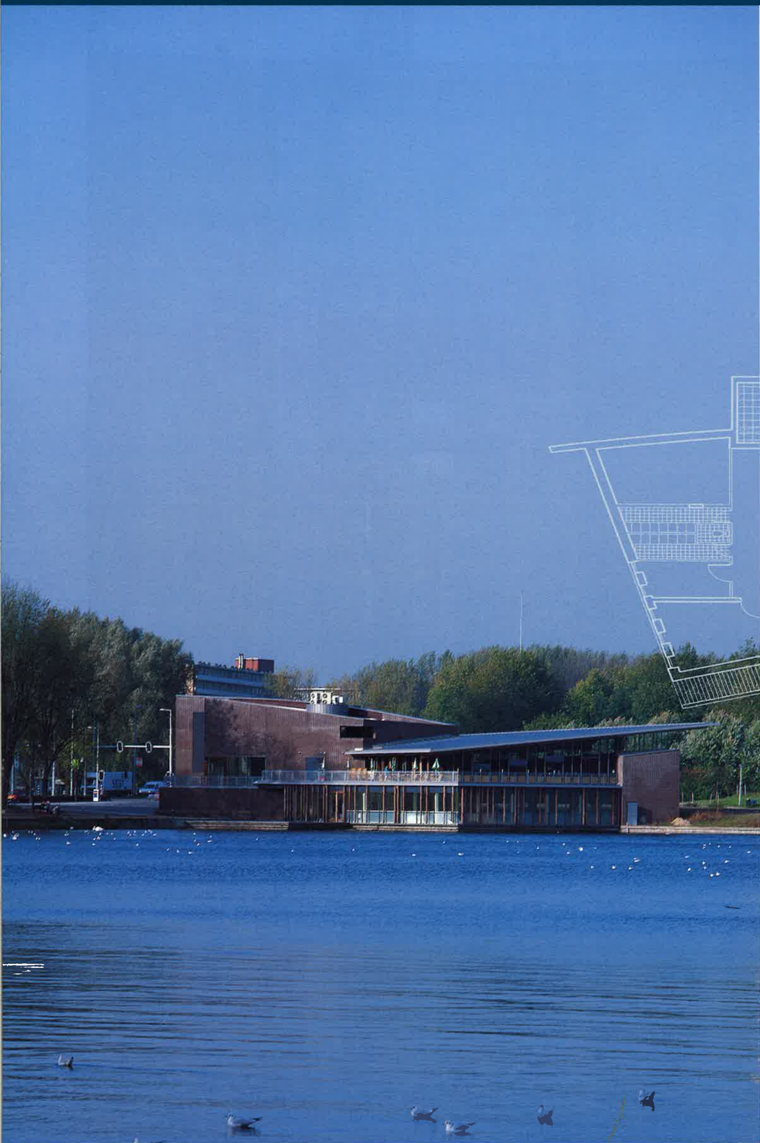
Restaurantcomplex Sloterplas, Amsterdam (Langram Architecten)
